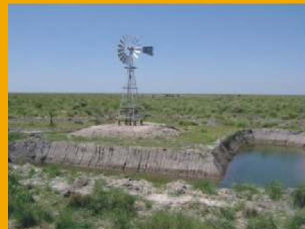
Foto de un pozo sistema araña y una represa de recarga.
